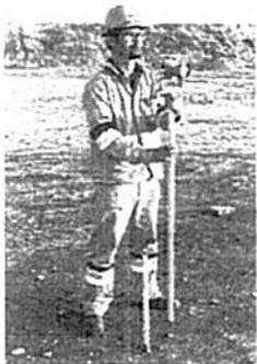
Finalizada a marcação desta poligonal, os topógrafos medem a posição de cada elemento do terreno em relação a ela. Esses dados são colocados em uma planta - a planta topográfica -, que será fornecida aos projetistas.
